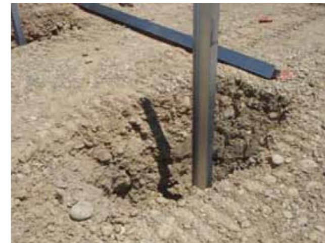
Photo 118 : fondation avec un pieu en acier galvanisé
