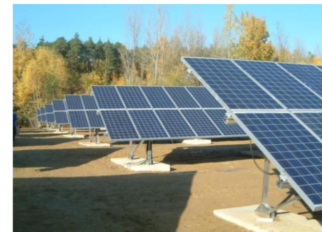
Photo 119 : fondation avec semelles béton
