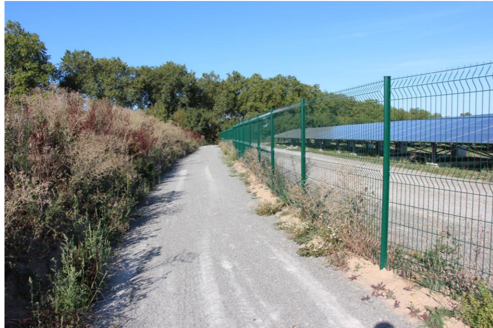
Photo 124 : exemple de clôture d'enceinte d'un parc photovoltaïque
